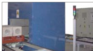
Produktionslinie mit 30kW Mikrowellen Kammeranlage zur Trocknung von Keramik Fertigelementen
